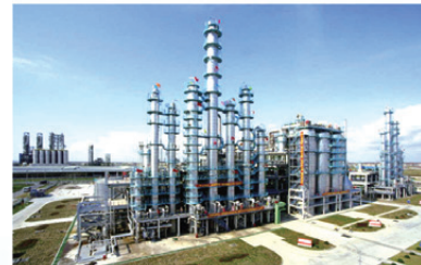
sistema de control industrial
