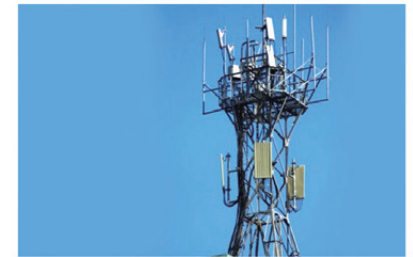
sistema de telecomunicaciones
