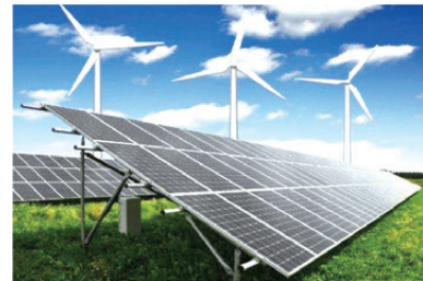
sistema de energía solar
