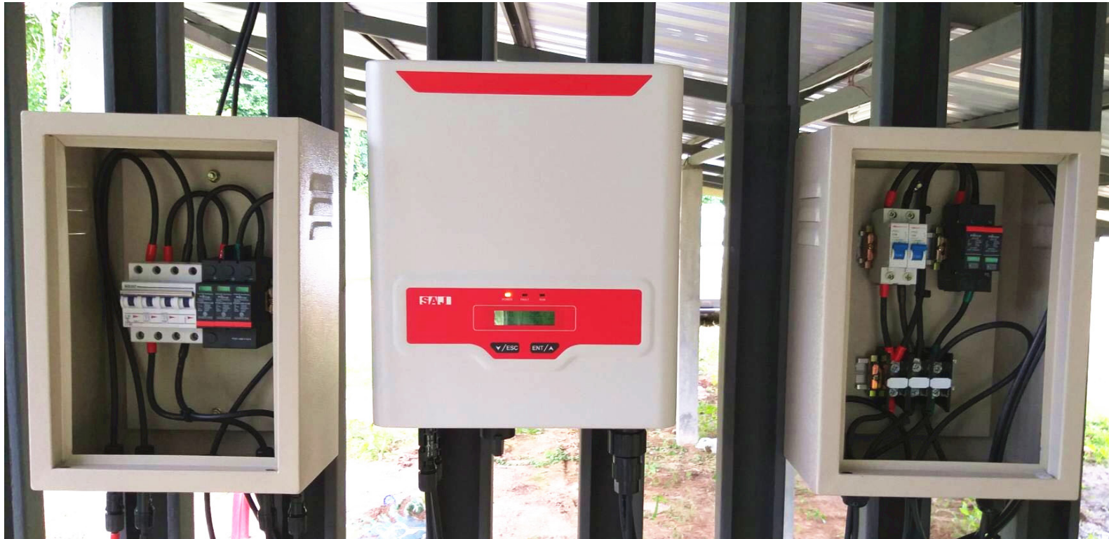
protector contra sobretensiones para sistemas de energía solar
