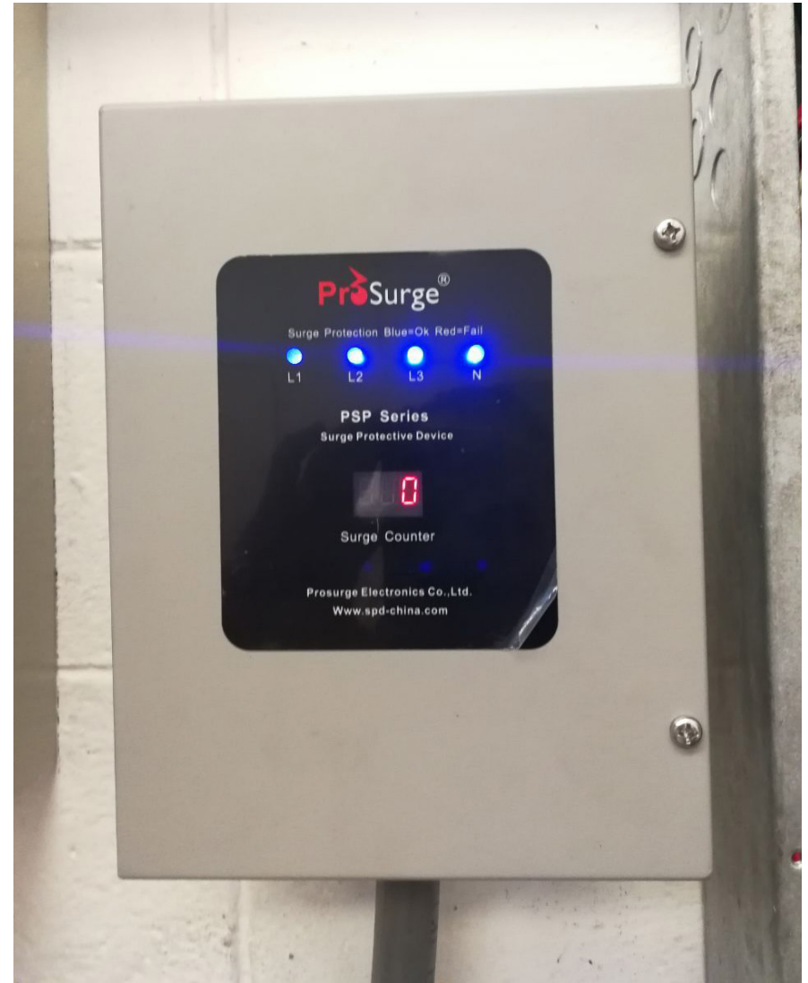
protector contra sobretensiones para el cuadro de distribución principal
