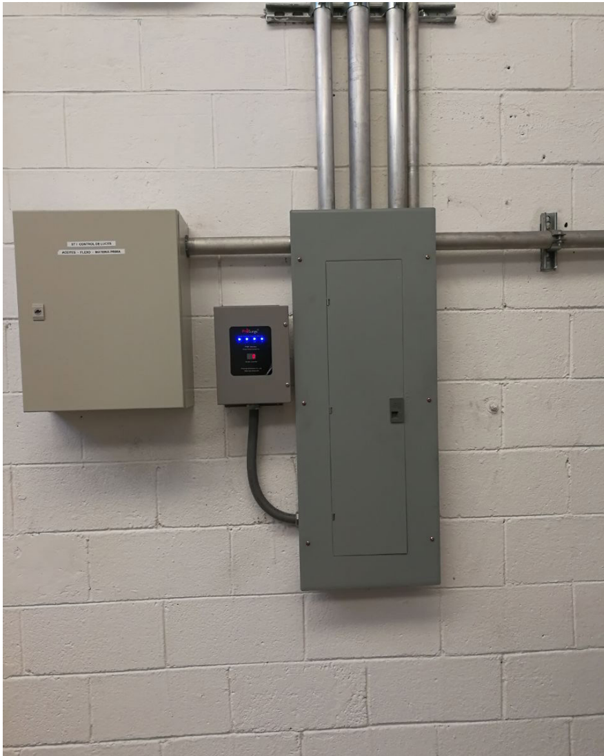
protector contra sobretensiones para el cuadro de distribución principal
