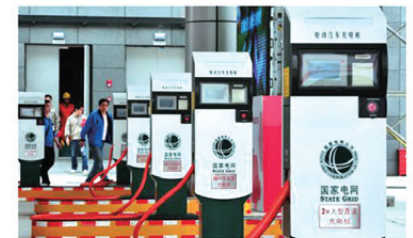
cargador para vehículos eléctricos
